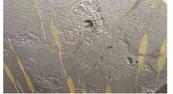
▲ Şekil 14b: Üst kısımdaki kum inklüzyonları
