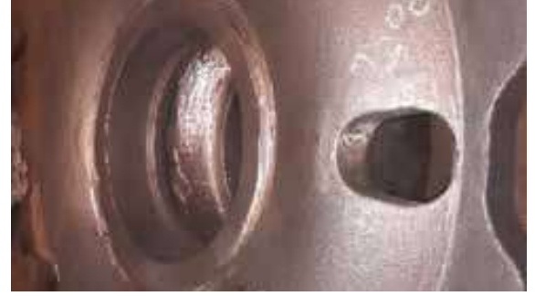
Şekil 12c: Menevişleme sonrası MPI çatlaması
